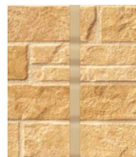
シーリング目地
